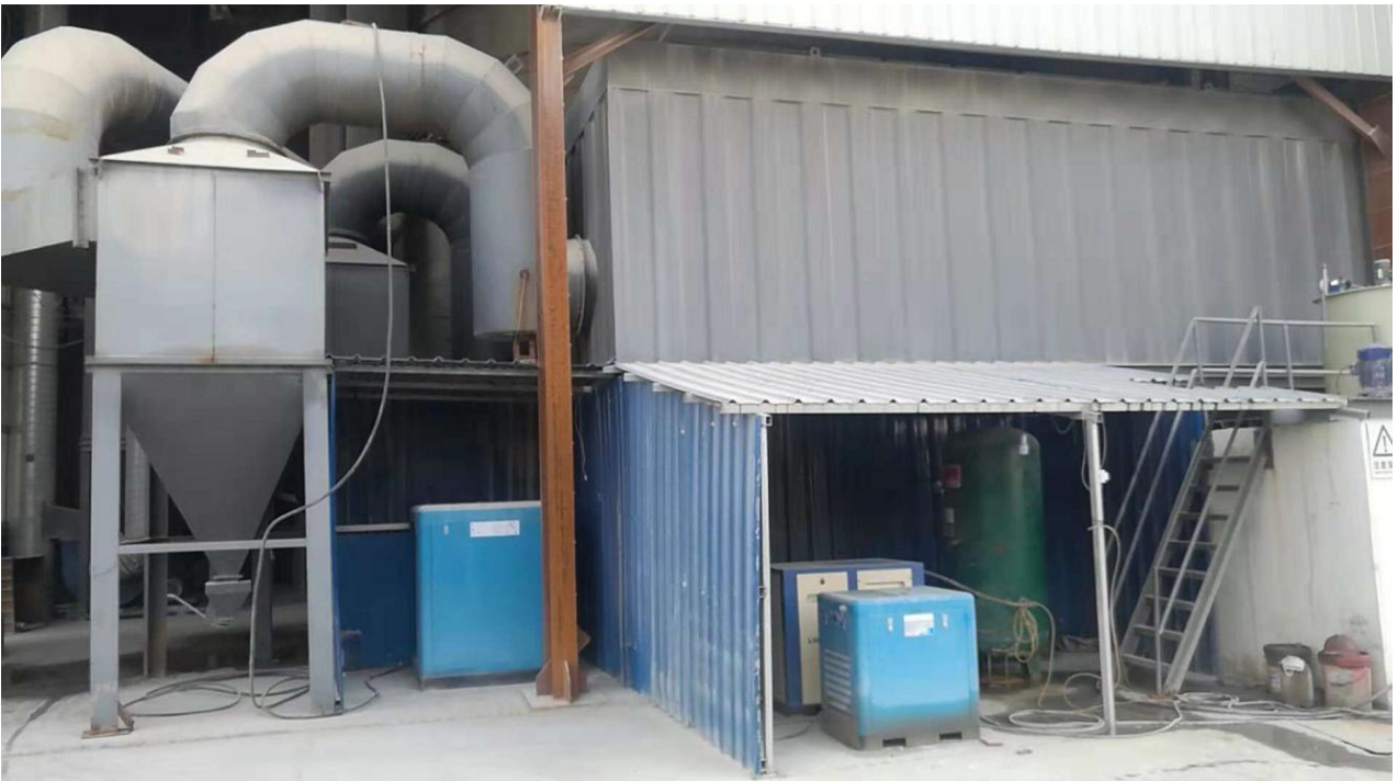
石灰窑除尘器及排气筒
