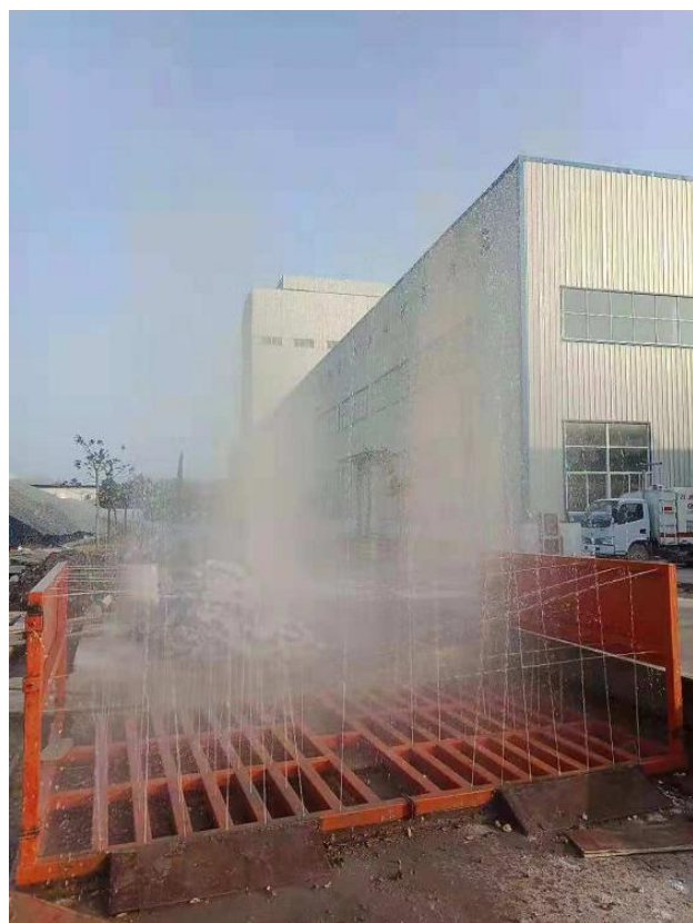
喷淋和车辆冲洗设备
