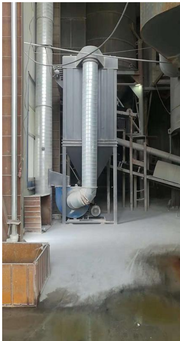
出灰集气罩、除尘器及排气筒
