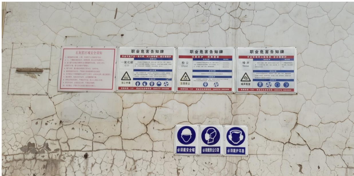
图6-2 用人单位车间设置的警示标识（部分）
